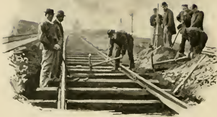
Abb 112a. Schwellen-Auswechslung auf der Strecke. [Nach Momentaufnahmen von J. Schneemann]
